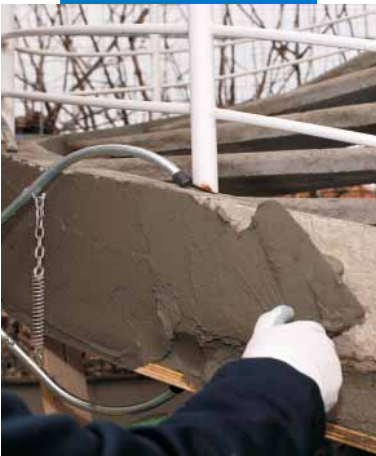
Nanoszenie Mapegrout 430 pacą
