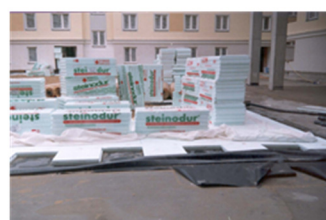
izolacja drogi pożarowej
